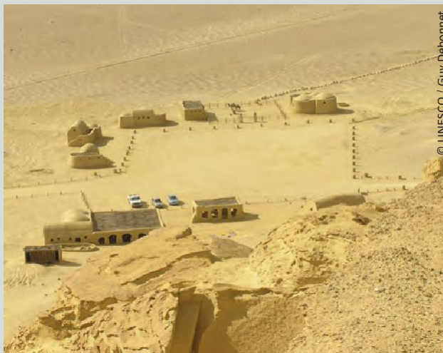
Сградите на управата на обекта и сградите за посетители — Вади Ал-Хитан (Долината на китовете) (Египет)
